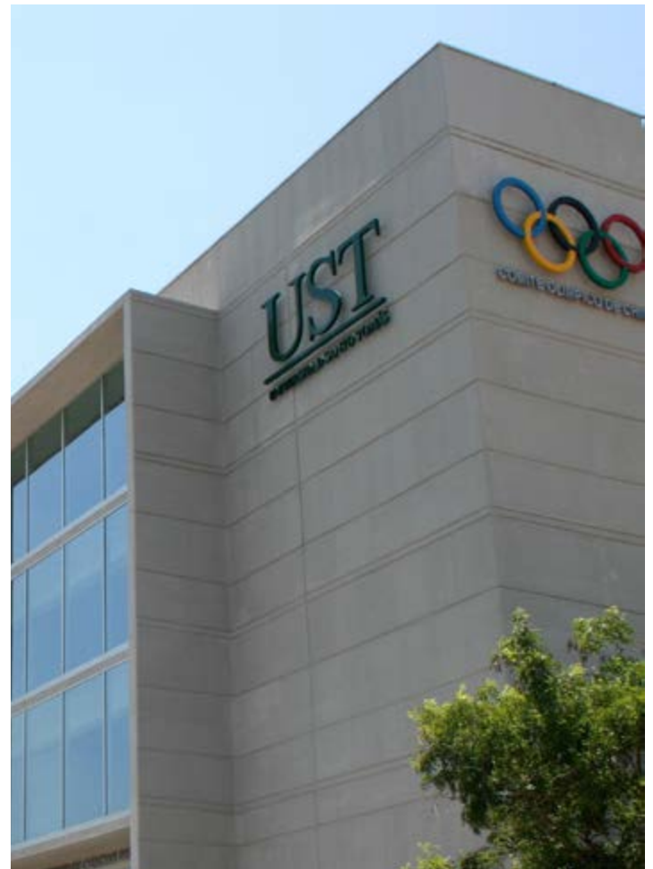
Edificio UST - Comité Olímpico de Chile.
